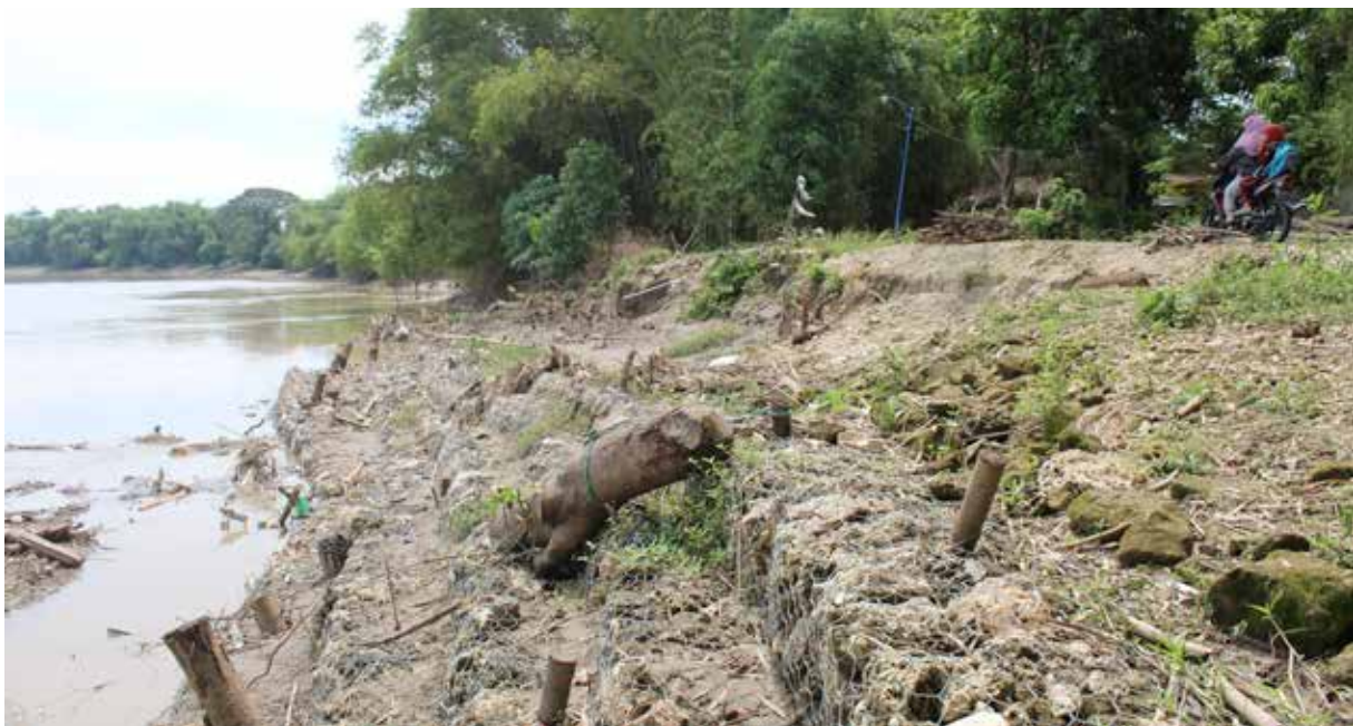
Tanah di Dusun Mlaten yang telah diberi penahan namun tetap ambles. Di kejauhan tampak barongan bambu menahan tanah dari pengikisan.
